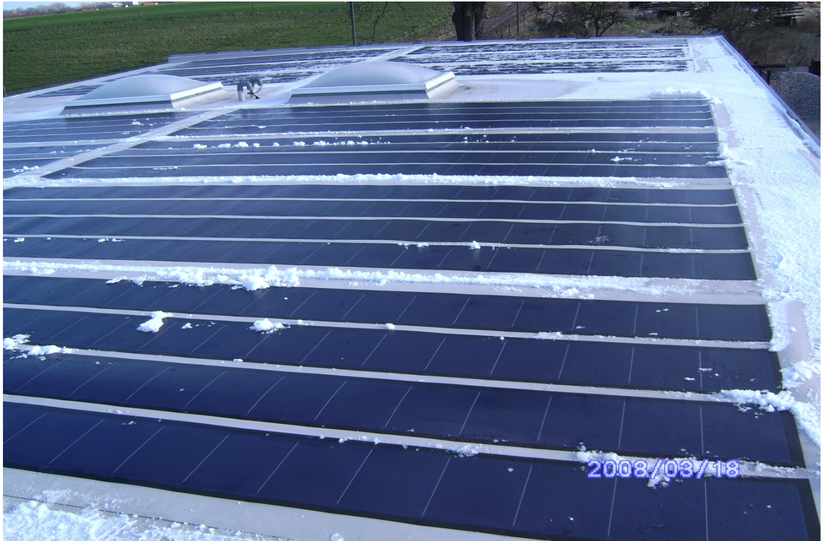
Anordnung flexible Module auf dem Dach
