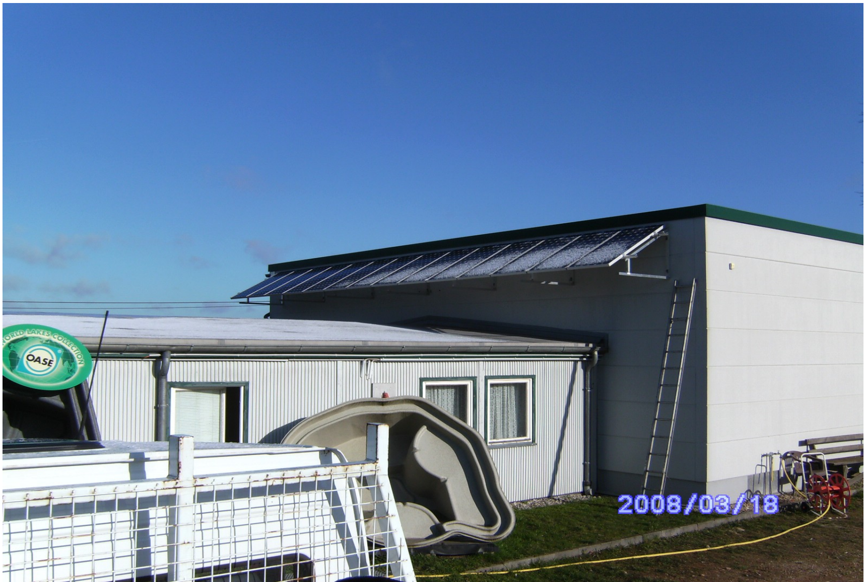
Anordnung kristalline Module am Giebel der Halle
